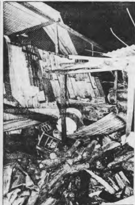
El tornado no respetó ni vigas de acero ni techos de NICALIT y como puede apreciarse en la parte superior izquierda de la foto, mientras abajo pareciera que la ciudad fue azotada por un violento terremoto. (Cortés).
